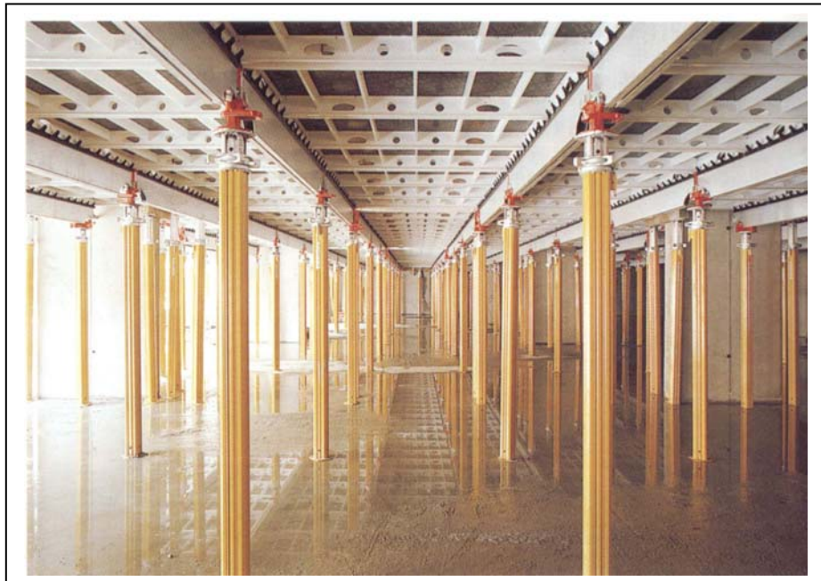
Figura 20 – Escoramento de laje Perri, chamado sky deck , com escoras, em amarelo, e painéis de forma mista, em branco, confeccionadas em alumínio e madeira. Em vermelho, o dispositivo drop head , para desmontagem do sistema.
