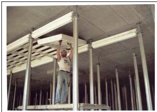
Figura 26– Detalhe de um catálogo do fabricante demonstrando como se desmontam as formas mistas (estrutura de alumínio com forma em madeira) , que estavam sobre as vigas horizontais de alumínio. O escoramento vertical é feito com escoras de alumínio.
