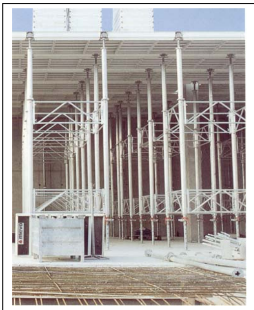
Figura 24 – Aspecto de uma obra típica de escoramento com equipamento da Meva. Escoras de grande capacidade sustentam verticalmente a laje, unidas por quadros em treliça. A laje é escorada por painéis de forma mista, em alumínio e madeira compensada resinada. Todo o equipamento de escoramento é em alumínio.
