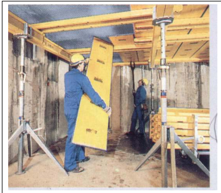
Figura 28 – Demonstração de montagem dos painéis de forma sob forma de chapas de madeira compensada resinada.
