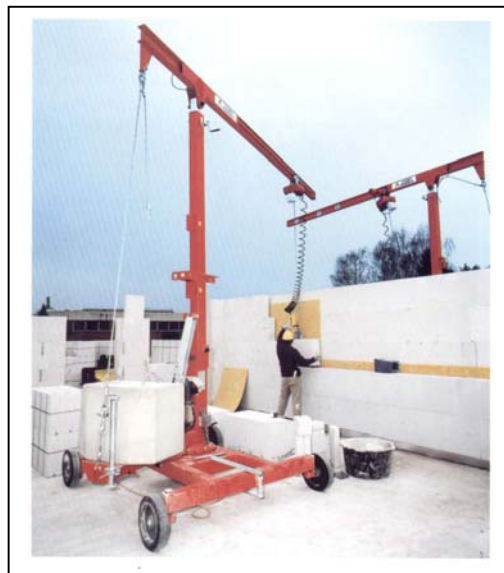
Figura 32– A Thyssen confecciona também este aparato que é uma máquina para assentar tijolos, que consiste em um guincho motorizado sobre um carro, controlado por um painel de manual, que posiciona os tijolos em sua posição.
