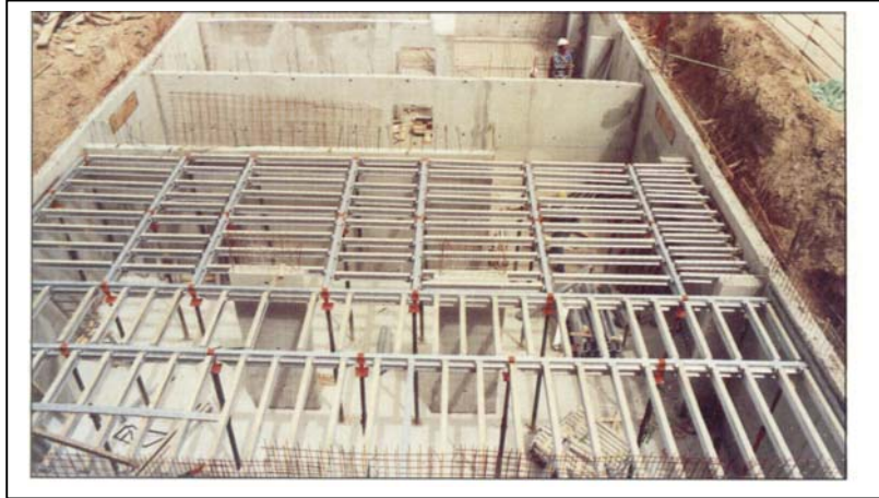
Figura 33– Vista aérea de uma montagem com equipamento SGB. As vigas horizontais são de alumínio e sobre elas serão montados painéis de madeira compensada como forma para concreto.
