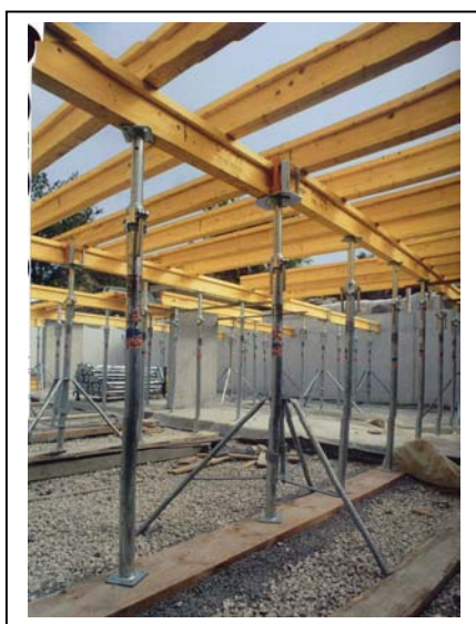
Figura 35 – Detalhe do escoramento da Paschal. Para escoramento vertical, escoras de aço. No escoramento horizontal, utiliza vigas de madeira, em amarelo.
