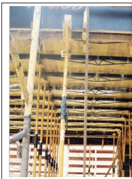
Figura 36 – Aspecto do equipamento da Ulma. O escoramento vertical é realizado com escoras de aço e o horizontal por meio de treliças de aço, sobre as quais apoia os painéis de madeira compensada resinada. O fabricante não possui nenhum equipamento em alumínio nem formas mistas.
