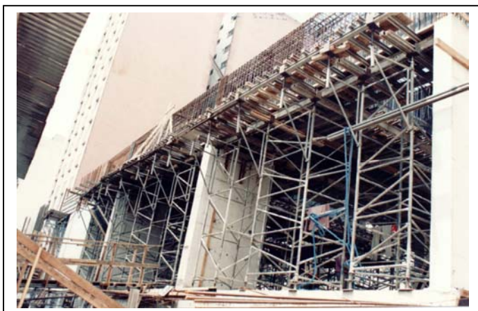
Figura 39 – Escoramento utilizando equipamento da Rohr. O escoramento vertical é feito com torres de quadros tubulares enquanto o escoramento horizontal é feito mediante vigas de aço, com as formas confeccionadas em madeira compensada resinada. O fabricante não possui painéis de forma mista.
